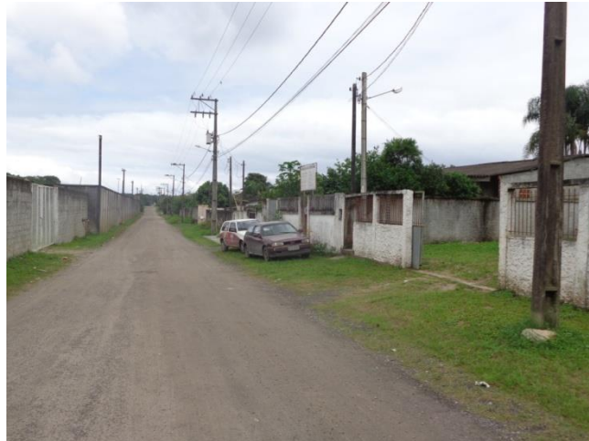
Figura 41: Rua 10, Bairro em processo de regularização. Fonte: Master Ambiental, 2014.
