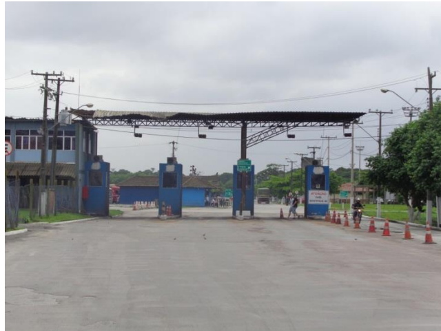
Figura 61: Pátio de Triagem de Caminhões de Paranaguá. Fonte: Master Ambiental, 2015.
