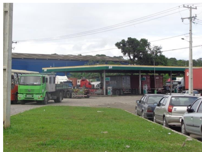
Figura 60: Posto de combustíveis instalado na BR-277. Fonte: Master Ambiental, 2016.
