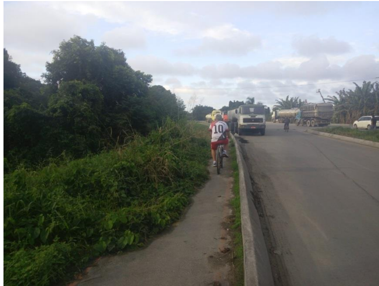
Figura 112: Falta de manutenção da vegetação rasteira na ciclovia próxima ao empreendimento.
