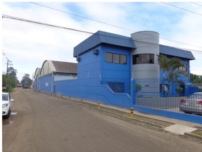
Figura 35: Edificação na Rua Beco 01. Fonte: Master Ambiental, 2014.
